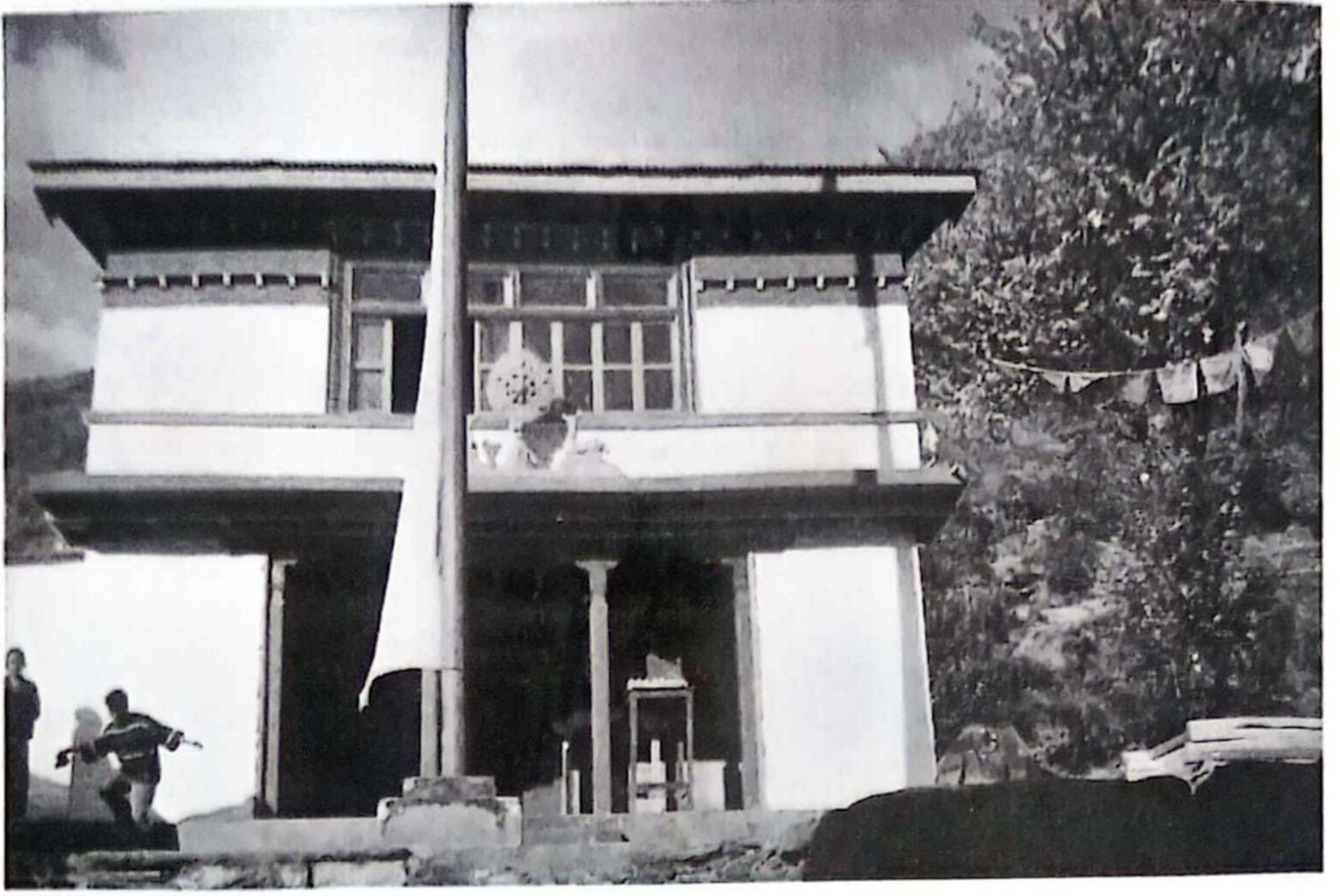
डुग पाल्देन फुन्छोगलीङ्ग गुम्बाको पुरानो भवन ।
